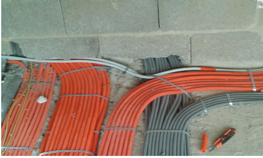
Resim 2.5: Bina tesisatlarında plastik borular
