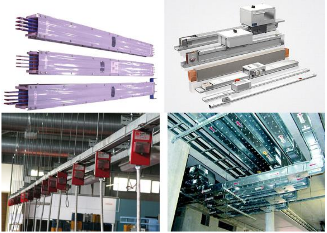
Resim 2.8: Busbar kanal enerji dağıtım sistemi
