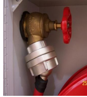
Fotoğraf 2.5: Yangın vanası ve montajı
